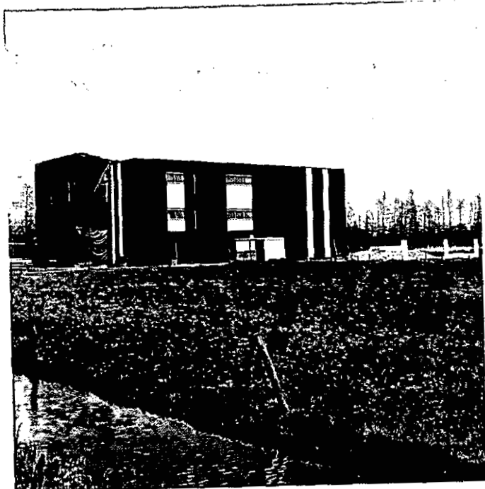
De nieuwe lage-snelheidswindtunnel LST 3 x 2,25 (Noordoostpolder) in aanbouw. The new low-speed wind tunnel LST 3 x 2,25 (Noordoostpolder) under construction.
