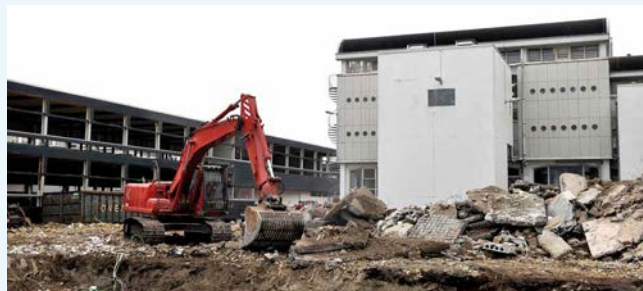
▲ Sloopwerkzaamheden in Amsterdam volop in gang
