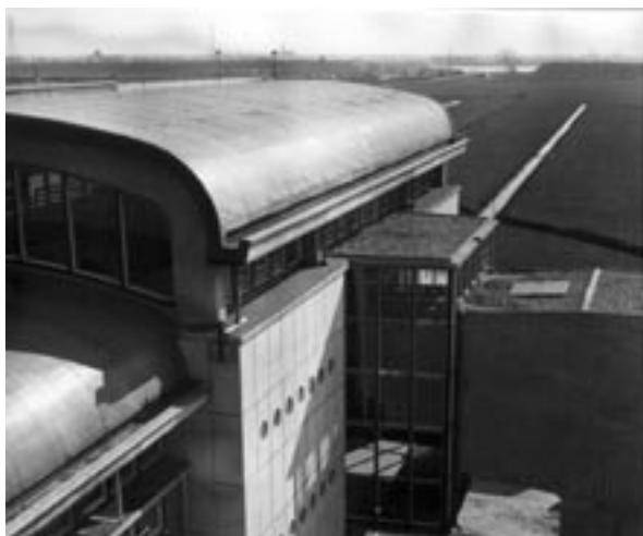
Lage Snelheids Tunnel gebouw in de jaren '40, waarin zich nu op de bovenste etage het museum bevindt
