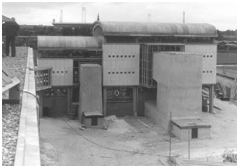
Het LST-gebouw in 1940, net uit de steigers
