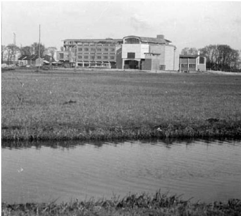
Het gebouwencomplex van het NLL te Amsterdam, gefotografeerd vor de bouw van de westvleugel
