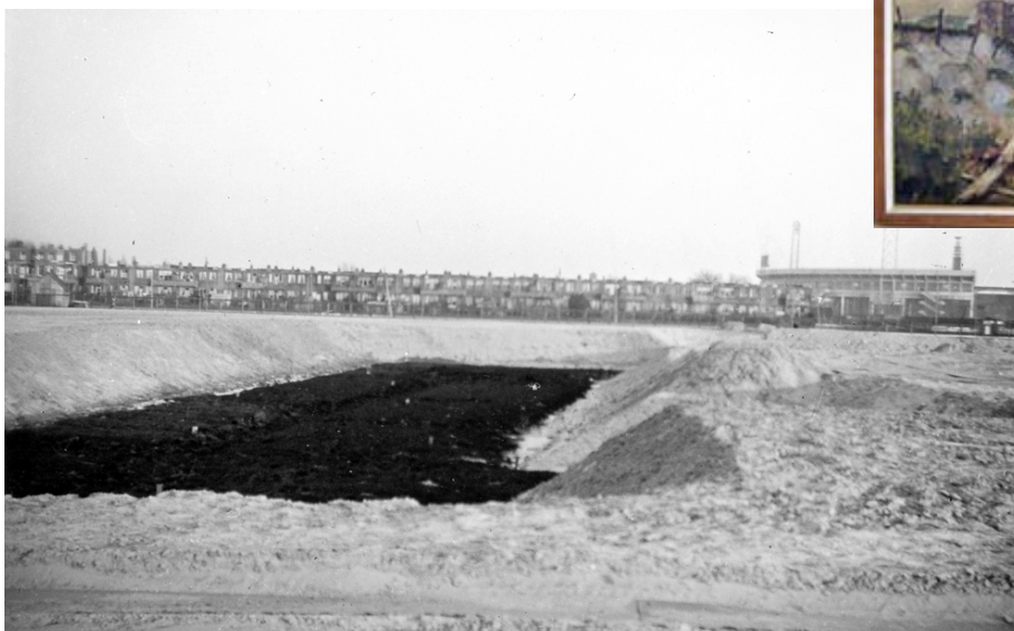
Bouwput NLL-gebouw (december 1938). De inzet toont een schilderij, waarop afgebeeld de bouw van de Westvleugel, in 1948.
