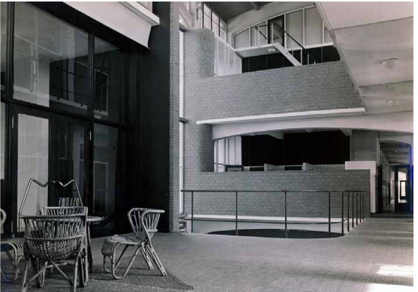
Hal voor de vergaderzaal en de directiekamer
