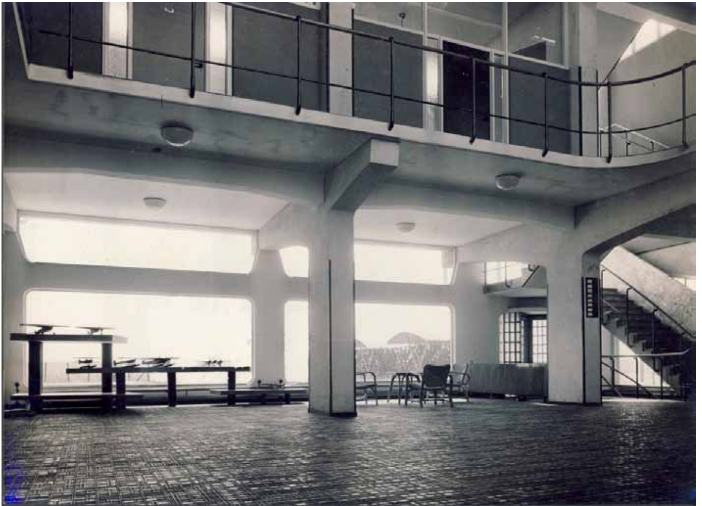
Entreehal gezien vanaf de hoofdingang
