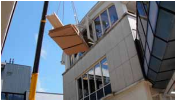
Het naar binnentakelen van de houten panelen voor de zolderetage [foto Kees Bakker]
