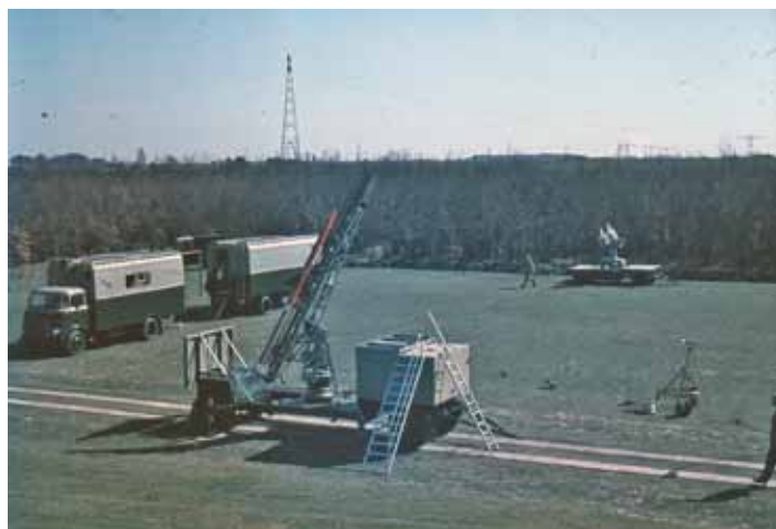
De commandowagen, de meetwagen, de antennewagen van het volgsysteem en de lanceerwagen staan opgesteld naast-achter het huidige R-gebouw op het NLR-terrein
