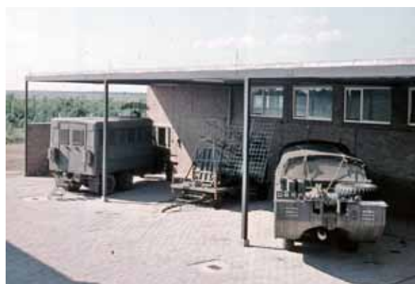
Deze foto is uit de beginjaren van de O-sectie, genomen op het NLR-terrein in de NOP. Onder het afdak staat de DUWK (een amfibievoertuig uit de dump). Deze werd gebruikt om op het wad te komen om het model terug te halen. De eerste antennewagen voor de dopplerezender en de eerste commandowagen staan ernaast (omstreeks 1962)
