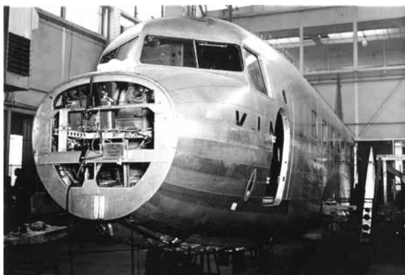
Een DC-2 voor de KLM in aanbouw bij Douglas
