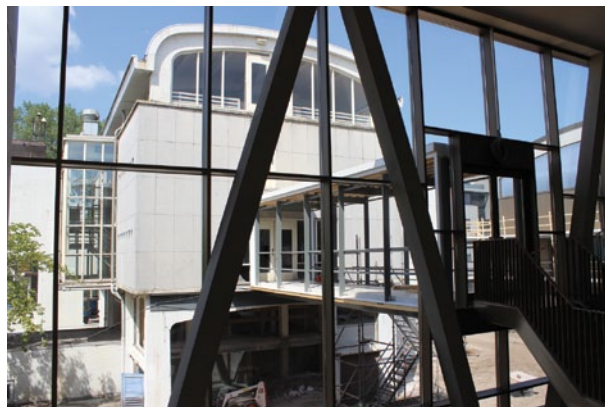
Opname vanuit het nieuwe gebouw 60 gemaakt naar gebouw 40, waartussen een loopbrug is gemaakt.
