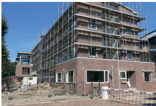
De voormalige portierswoning van het NLR; laatste hand aan de renovatie.
