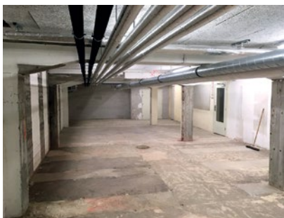
De lege kelder, wachtend op afwerking van vloer en wanden.
