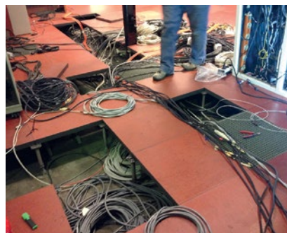
Km kabels worden gelabeld, ontward en onder de vloer vandaan gehaald.
