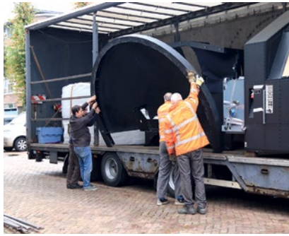
De bovenschaal met kwetsbare projectoren wordt met de hand op de truck geplaatst.
