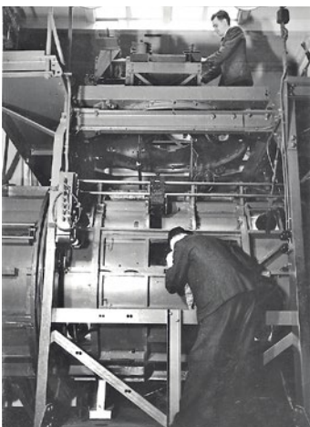
Afb. 4 Gesloten meetsectie van de Eiffeltunnel; boven de tunnel de balans waarmee de krachten op het model konden worden gemeten.
