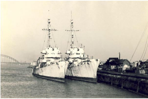
afb. 2 De HMS Duff en Ekins, twee van de drie zgn. Escortschepen waaruit de turbo-elektrische installaties voor de NLR Centrale afkomstig waren. Deze schepen werden door Engeland tijdens de oorlog 'geleased' van Amerika
