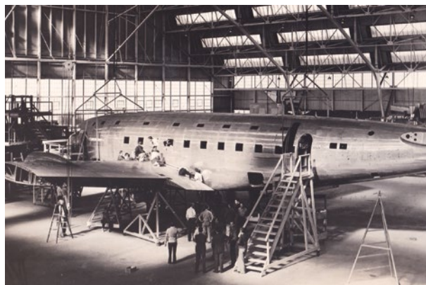
DC-4 in aanbouw (7 februari 1938) (bron: NLL-rapport RB.268)
