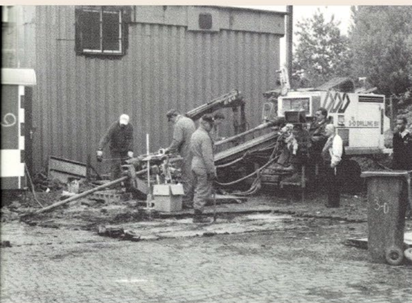
Boring onder de Schinkel door.
