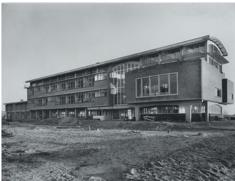
Het nieuwe hoofdgebouw van het NLL aan begin van het uitbreken van de Tweede Wereldoorlog
