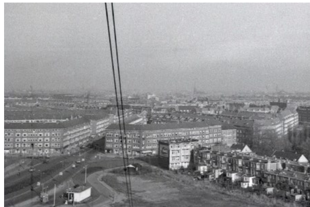
Opname vanuit een 45m hoge mast met zicht op Osdorp in aanbouw
