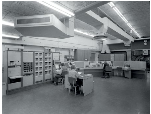
De regelkamer van de HST na de installatie van het: "Eerste Geheel Online Instrumentatie Systeem Tunnels" (EGOIST), op de foto links. Het systeem, dat werd bestuurd door een HP2100 computer, werd operationeel in 1973.
