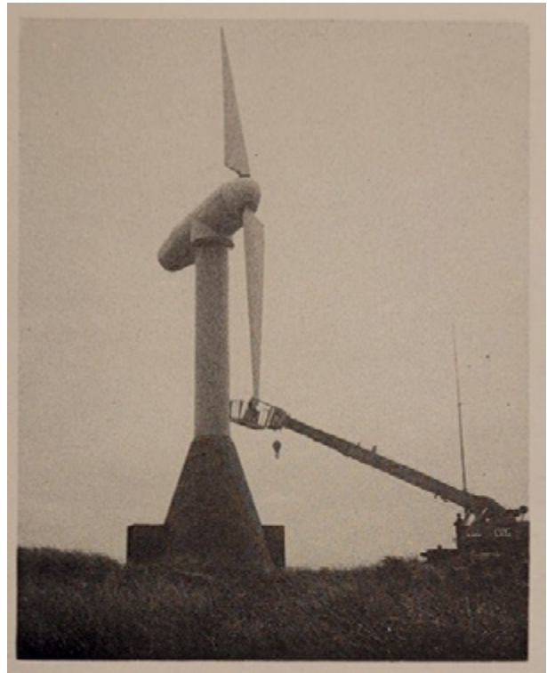
Fig. 10 Standtillingsonderzoek aan een 25 m windturbine in Petten
