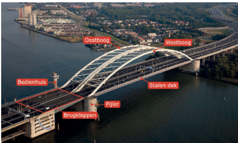
Fig. 4 De Van Brienoordbrug
